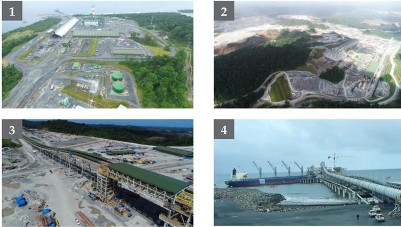
Nota: la placa fotográfica ilustra la escala de las instalaciones industriales de la mina Minera Panamá. Además de la planta de procesamiento de rocas (fotografía 2), el complejo incluye una central eléctrica alimentada por carbón (fotografía 1) y un puerto de aguas profundas (fotografía 4). La fábrica y el puerto están conectados a través de una cinta transportadora de varias decenas de kilómetros (fotografía 3).
