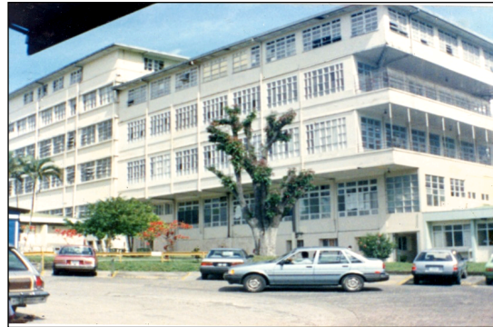
Figura 2. Edificio Sección de Medicina – HSJD 1964-1993.
