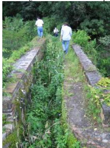
3. Vistas del ingenio El Rosario. Izq. Caída de agua, corresponde al cuadro en negro dentro del plano. Der. Vista del interior de la canaleta
