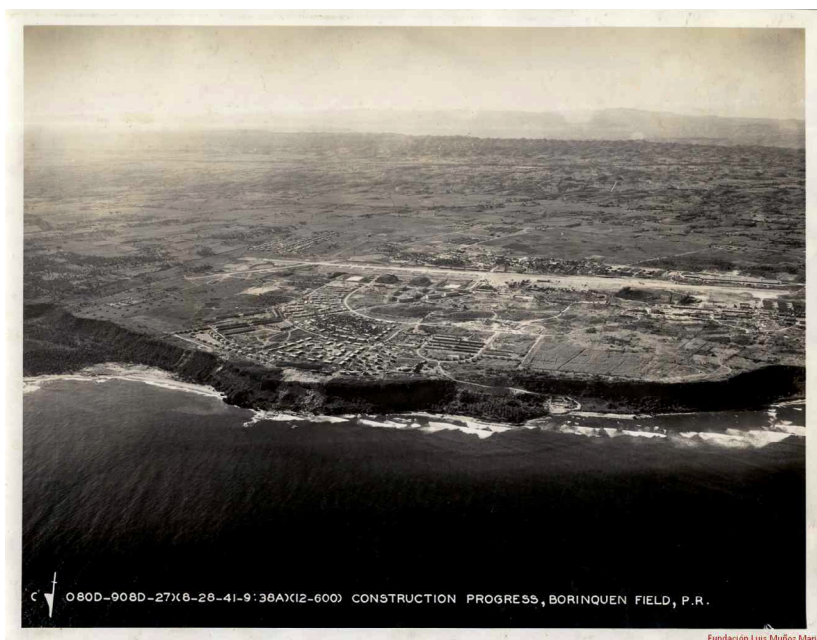
Figura 2. Construcción de la base Borinquen Field en el municipio de Aguadilla, para las Fuerzas Armadas del Ejército de los Estados Unidos. Fundación Luis Muñoz Marín, colección José Orraca Pérez. Versión digital www.flmm.org
