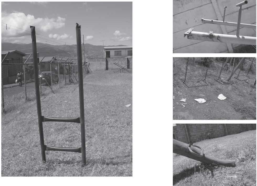
Ilustración 5. Aparatos en mal y muy mal estado en los campos de juego.
