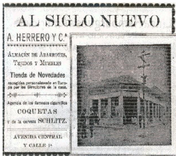
Almacén “El siglo Nuevo S.A.”
