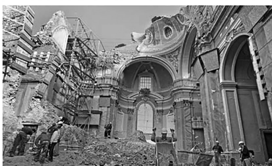
Fig. 7: El centro histórico de L'Aquila, afectado por el sismo del 9 de abril de 2009 (Kington, 2012).
