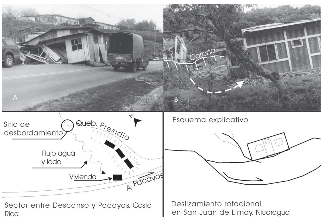
Fig. 4: A. Casa afectada en 1997 por desbordamiento de la Quebrada El Presidio en coordenadas 558,30-209,08. Los rectángulos negros de la derecha corresponden con las viviendas ubicadas sobre una colina alargada y que se observan detrás de la vivienda afectada. La Quebrada El Presidio tiene su cauce detrás de la colina. En el esquema sin escala, el sitio del desbordamiento se encuentra aproximadamente 500 m de distancia de la vivienda afectada. Se muestra en la fotografía el esquema para entender el problema. Foto, G. Peraldo. B. Vivienda destruida e inclinada por un deslizamiento rotacional ubicado en el Departamento de Matagalpa, Nicaragua, durante el huracán Mitch. Foto G. Peraldo.
