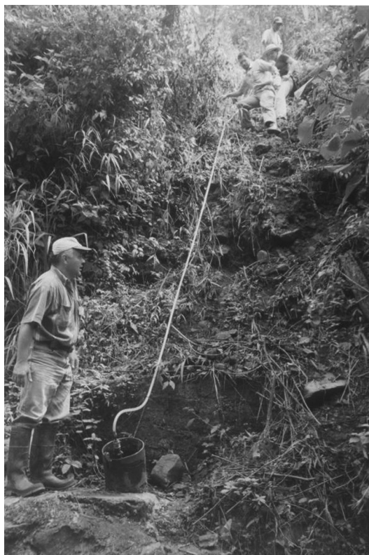
Fig. 4: Instalación de mangueras para lecturas en el piezómetro.
