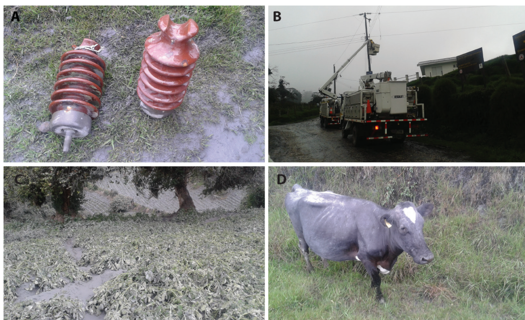
Fig. 1: Ejemplos de pérdidas ocasionadas por la actividad de cenizas del volcán Turrialba en mayo del 2016: a) Aisladores de porcelana dañados, b) Limpieza de transformadores y aisladores, c) Pérdidas de los cultivos, d) Ganado de leche con ceniza.
