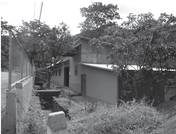
Fig. 5: Edificio donde se ubicó la planta embotelladora de agua mineral Las Piedras (1955 – 1963) en Salitral de Santa Ana.
