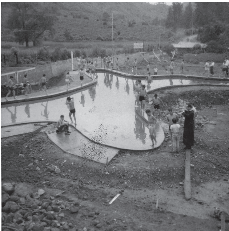
Fig. 7: Balneario Los Patios, Orosi de Cartago, en construcción y uso en setiembre de 1969 (cortesía de Adrián Mora A.).
