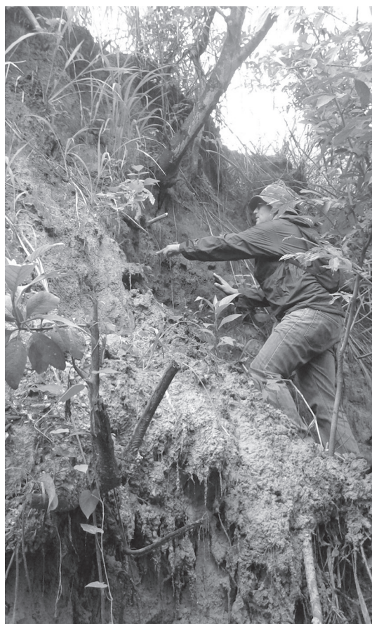
Fig. 13: Talud TBJ, ubicado en Autopista San Salvador – San Miguel (Carretera de Oro), al Poniente del colegio Padre Arrupe, Soyapango. (punto 6 de Fig. 5).
