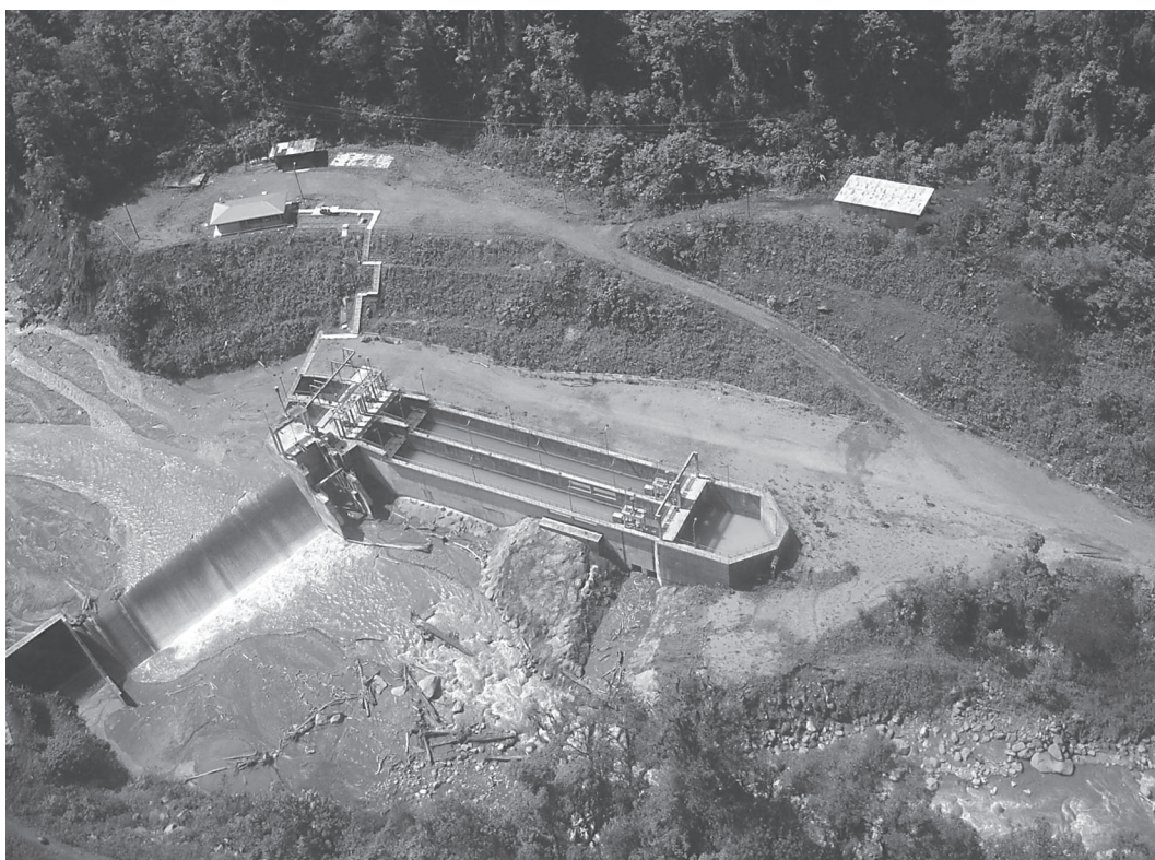
Fig. 19: Efectos relativamente menores de los flujos de lodo sobre la presa del Sarapiquí (Fotografía: E. Campos).
