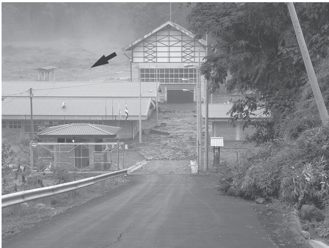
Fig. 15: El flujo transitando por la Casa de Máquinas y otras instalaciones de Cariblanco. Se observa en el cauce del río las antidunas (régimen supercrítico) y la parte tranquila del flujo (subcrítico) señalada con la flecha, así como las oleadas en la puerta principal de la Casa de Máquinas (Fotografía de G. Hernández, a las 13: 47 h del 8 de enero, 2009).
