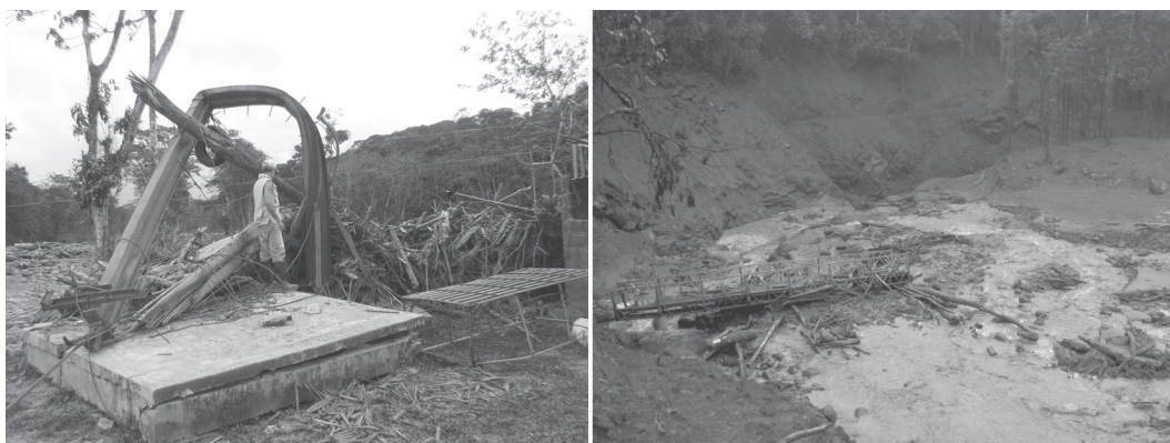
Fig. 20: A la izquierda se pueden observar los efectos dejados por el flujo del 8 de enero en la caseta de un andarivel y las retorceduras de los postes de acero. A la derecha, el Puente "Bailey" arrasado unos 75 m por el flujo del río Ángel del 21 de enero de 2009.
