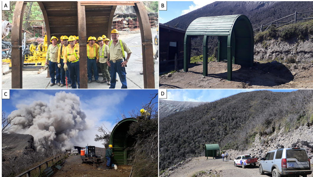
Fig. 4: Ejemplo de algunos de los refugios antibombas, construidos en las instalaciones del ICE de la Garita (A), durante su proceso constructivo, e instalación y finalización en el volcán Turrialba (B, C y D).
