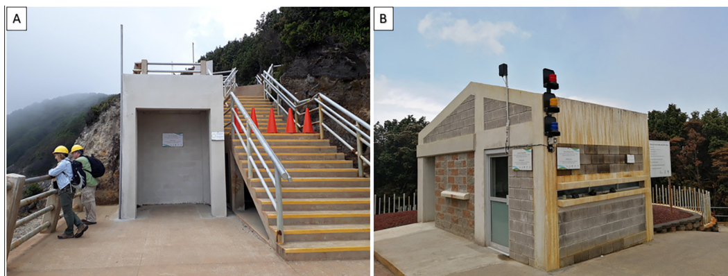
Fig. 3: Refugios de protección parcial y temporal antibalísticos volcánicos en el mirador del Poás.
