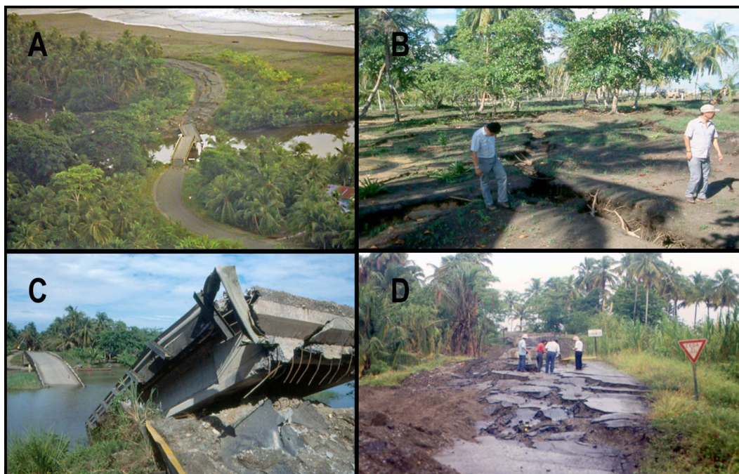
Fig. 8: Licuación, separación lateral y subsidencia en las cercanías de la desembocadura del río Bananito. A: Aspecto del colapso del puente, separación y agrietamiento del terreno en los alrededores del puente del río Bananito; 3 de mayo de 1991. B: Terrenos en la margen izquierda del río Bananito, cerca de su desembocadura. C: Puente colapsado del río Bananito. D: Licuación, agrietamiento y separación lateral de la carretera y rampa de aproximación del puente sobre el río Bananito. Fotografías tomadas por Sergio Mora Castro el 11 de mayo de 1991.
