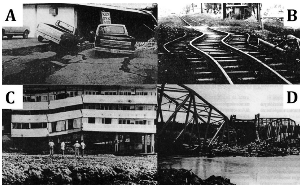
Fig. 14: Principales efectos de la licuefacción en Costa Rica y Panamá: A) Grietas en las oficinas de la Chiriquí Land Company en Changuinola debido a desplazamientos laterales. B) Daños en el puente del ferrocarril en Changuinola, Panamá, debido a desplazamientos laterales. C) Hotel Las Olas en la ciudad de Limón, parcialmente colapsado, sus bases fueron construidas sobre material coralino. D) Puente sobre el río La Estrella colapsado debido a la falta de mecanismos de soporte para mitigar los desplazamientos laterales. Las imágenes A y B fueron tomadas de Camacho y Viquez (1994) y las imágenes C y D de Sauter (1994).
