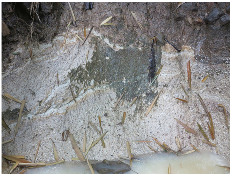
Fig. 7: Toba de pómez argilizada/meteorizada en la base del deslizamiento de Las Colinas; obsérvese las fisuras de corte iniciales pudiendo estar relacionadas a reptación. (13,6625077°, -89,2856874°).
