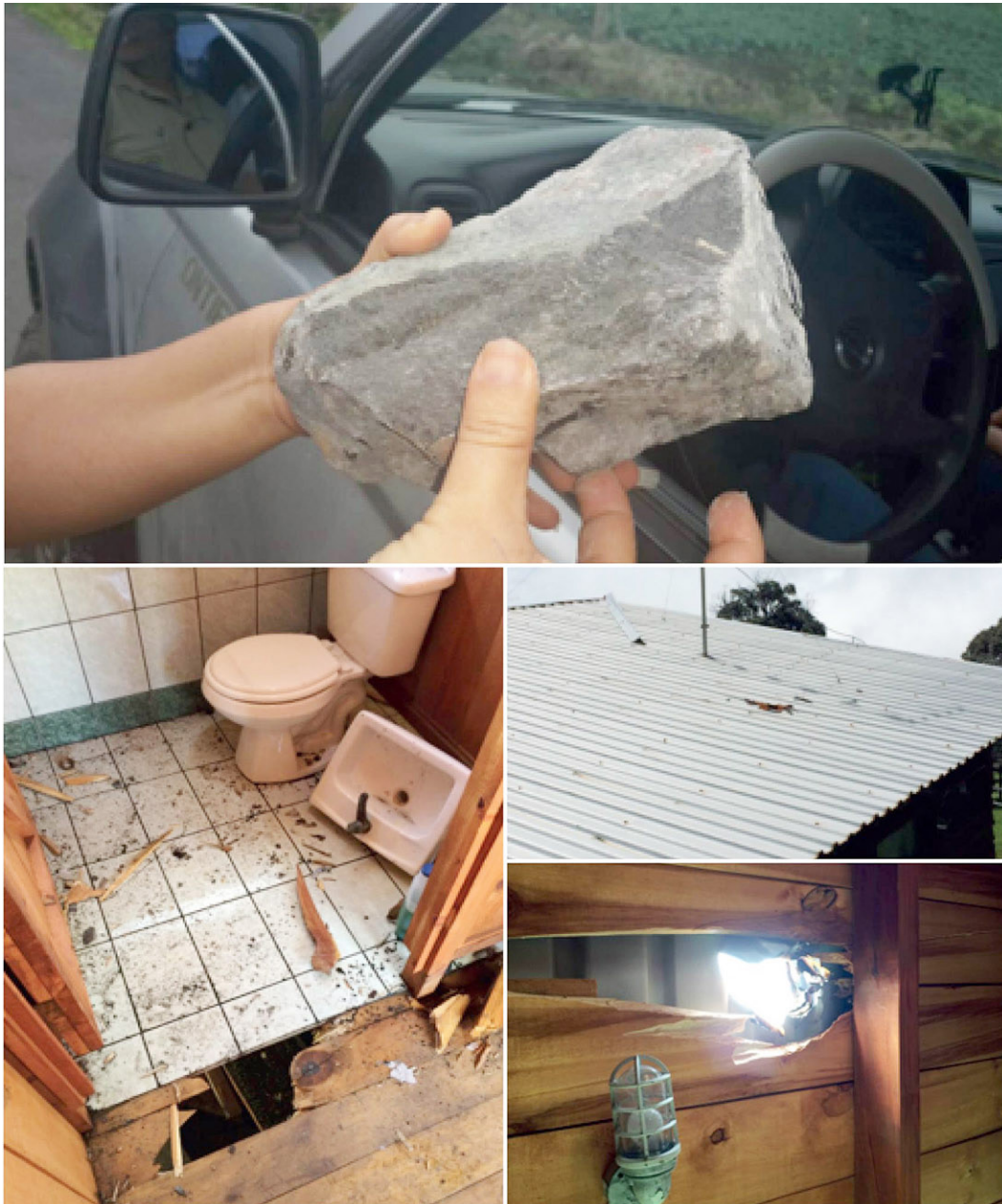
Fig. 2: Daños causados por el fragmento mostrado en la última fotografía (cortesía R. Sánchez).
