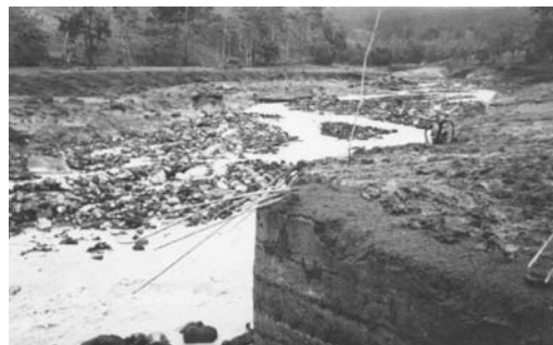
Fig. 10: Lahares en el río Pénjamo, con el puente arrasado, el 8 de mayo de 1991 (Foto de archivos del ICE).
