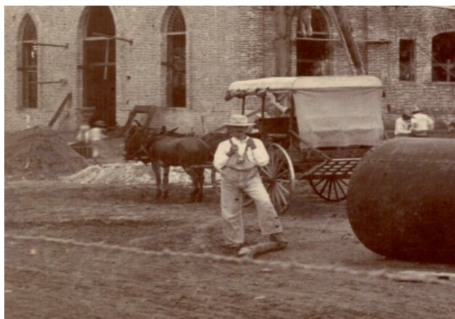
El ingenio de Eldorado en plena construcción. Junto al edificio una Araña, transporte regional tirado por caballos que se usó todavía hasta el año 1960 en Culiacán y Eldorado. Colección particular 1901.
