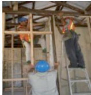
Sustitución de piezas estructurales en el edificio 4654-A.
