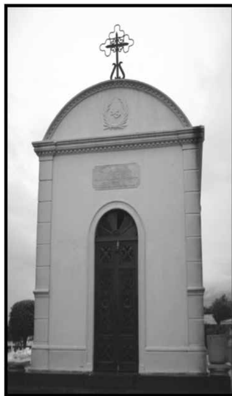
Tumba-Capilla de la familia de don Bernardino de Peralta y Alvarado. Material: ladrillo con repello de concreto. Construcción de tipo neoclásico, con fachada simétrica y acceso a cripta por dentro. En la puerta de acceso —diseñada en bronce florentino— aparecen los ángeles solamente representados por la cabeza y las alas en un círculo. Fotografías Guillermo Brenes Tencio.
