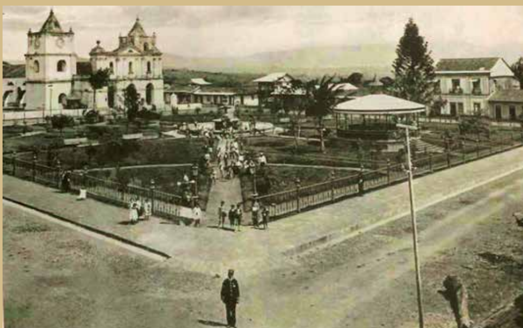
3.4. Parque de la ciudad de Heredia a inicios del siglo XX. En el centro, se aprecia la fuente de hierro. A la izquierda, el templo parroquial de la Inmaculada Concepción. Foto: Fernando Zamora.
