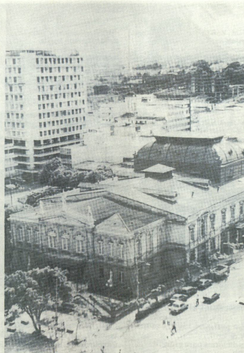
Foto 2. Densificación horizontal y vertical de la ciudad de San José
