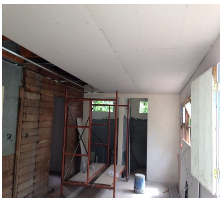
Fig. 11: Iglesia de Toledo, batería de baños. Autor: Archivo personal, 2017.
