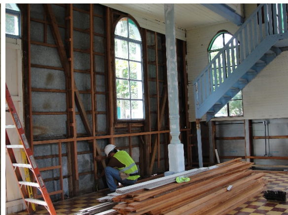
Fig. 6: Iglesia de Toledo, reconstitución de forros de madera. Autor: Archivo personal, 2016.
