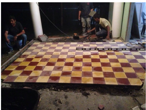
Fig. 24: Iglesia de Toledo, sustitución de piso de atrio. Autor: Archivo personal, 2017.
