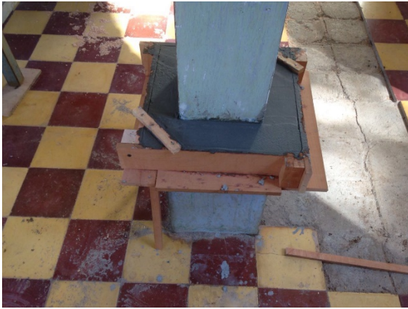
Fig. 19: Iglesia de Toledo, reconstrucción de pedestal. Autor: Archivo personal, 2017.
