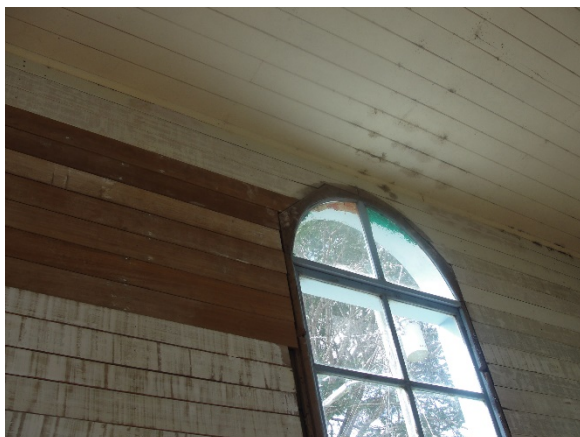
Fig. 5: Iglesia de Toledo, reconstitución de forros de madera. Autor: Archivo personal, 2016.
