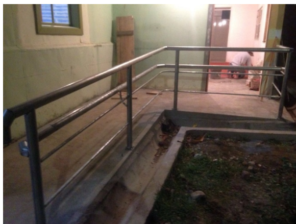
Fig. 22: Iglesia de Toledo, construcción de rampa. Autor: Archivo personal, 2017.
