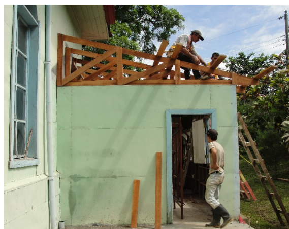
Fig. 4: Iglesia de Toledo, sustitución de cerchas de madera. Autor: Archivo personal, 2016.
