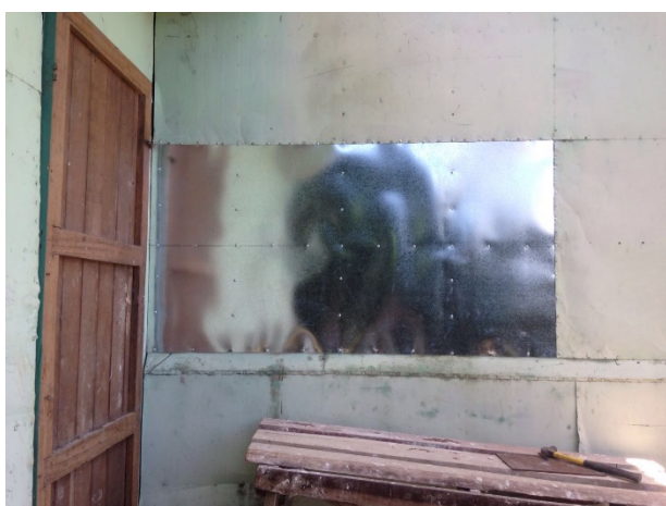
Fig. 17: Iglesia de Toledo, reconstitución de forros metálicos. Autor: Archivo personal, 2017.
