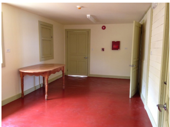
Fig. 23: Iglesia de Toledo, nuevos forros y cielos de sacristía. Autor: Archivo personal, 2017.
