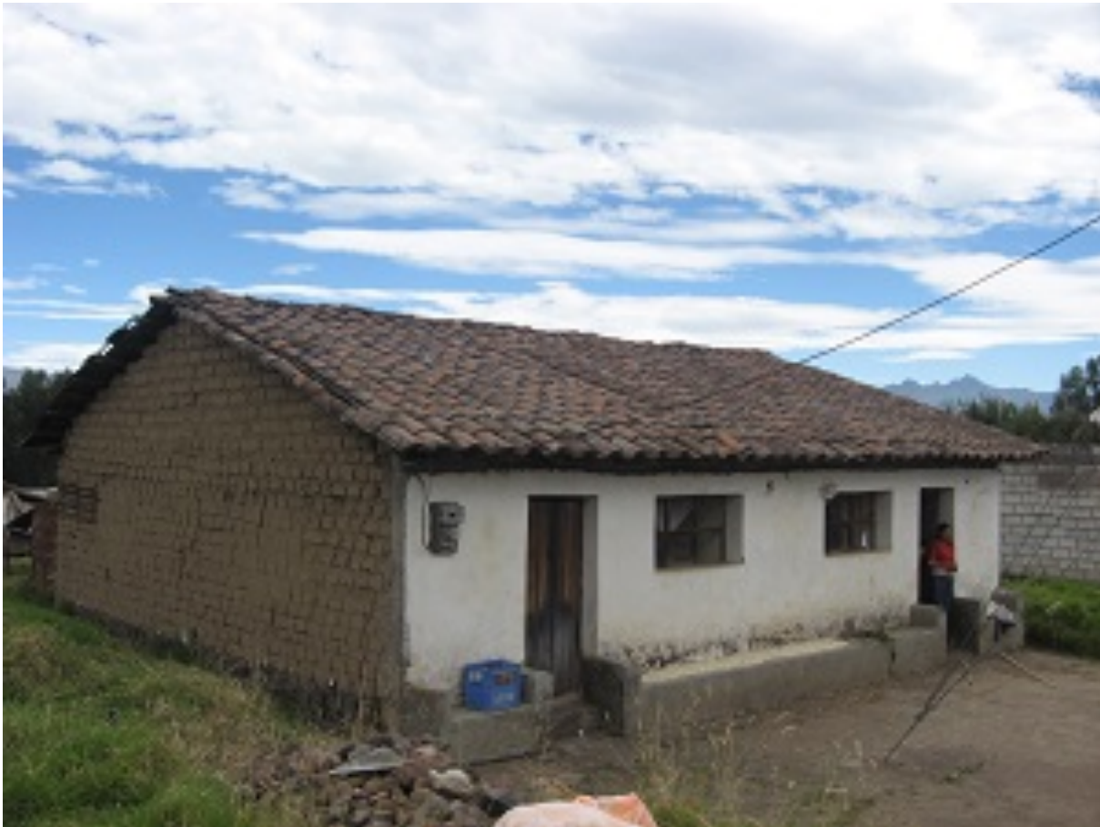
Figura 6. Tipología de cubierta a dos aguas, de teja con estructura de madera
