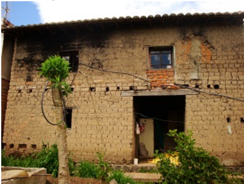
Figura 5. Fachada vivienda de adobe sin enlucir
