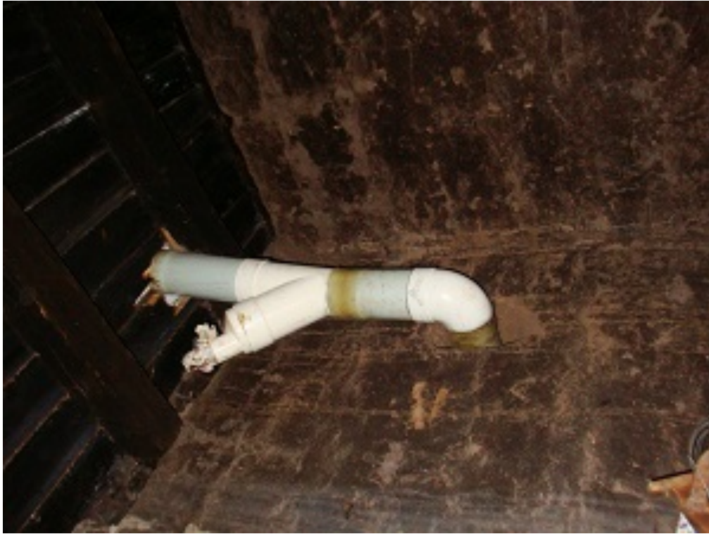
Figura 10. Perforación del piso de madera para instalación sanitaria
