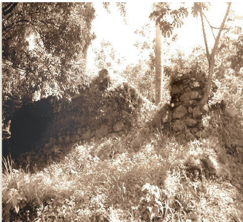
Estado actual del muro de la Antigua Aduana, declarado bien patrimonial.
