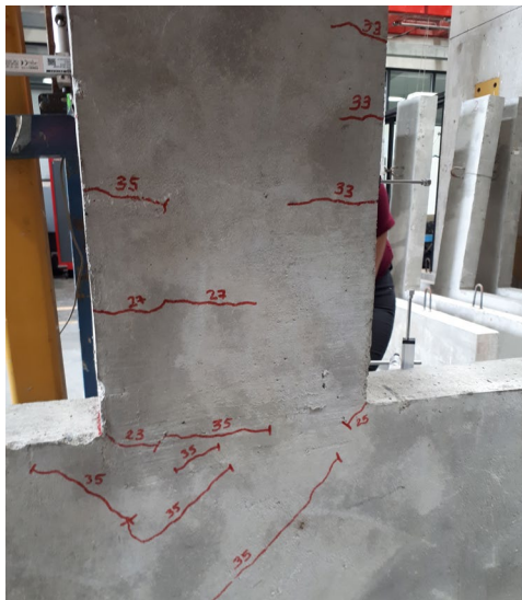
Fig. 11. Mapeo de grietas en los especímenes.
