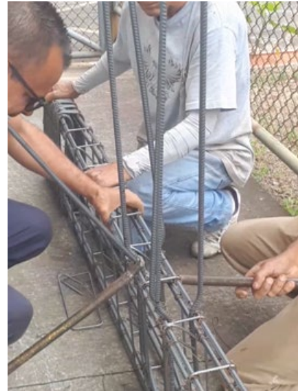
Fig. 5. Proceso de grifado de la unión Tipo A.
