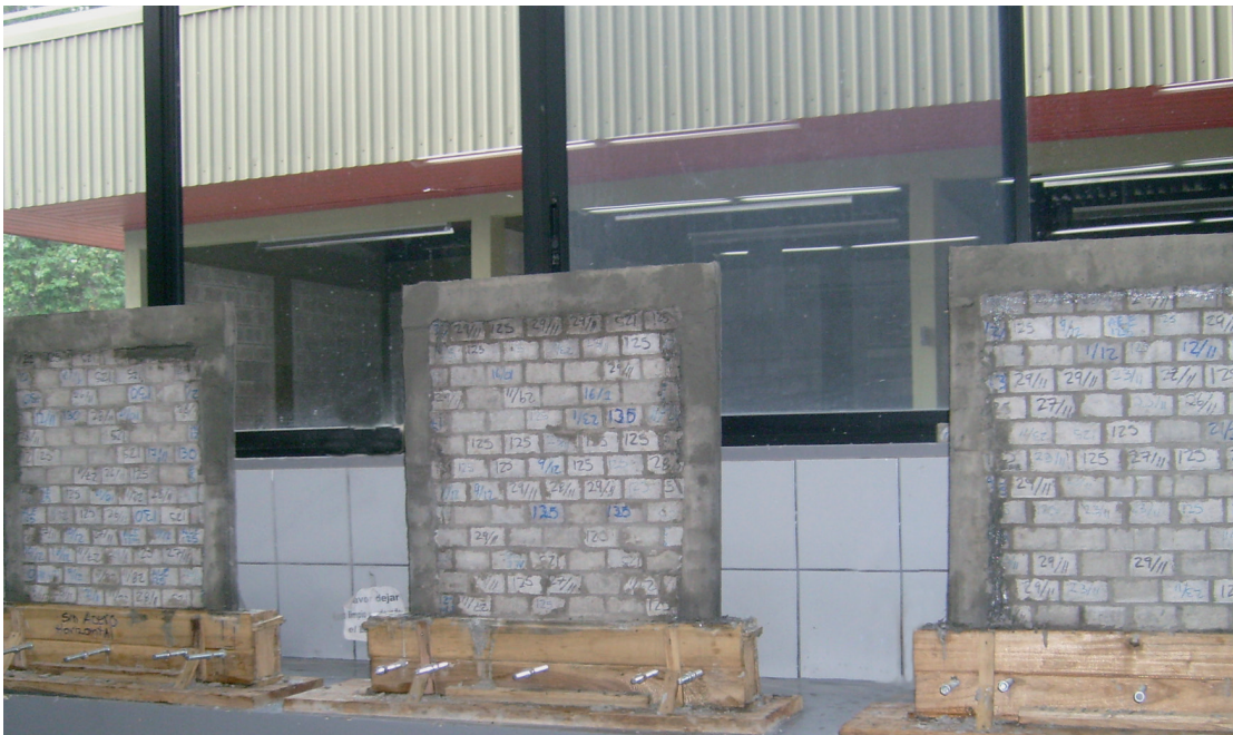
Figura 3. Muros terminados. Fuente: Sáenz, 2009.
