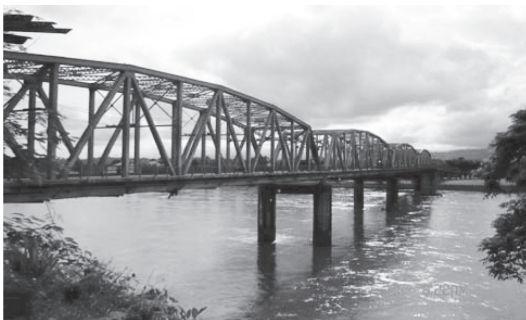
Figura 9. A la izquierda, nave elegida para ser instrumentada, de las cuatro simétricas que constituyen el puente en su extensión total.
