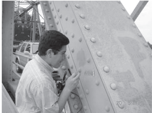
Figura 12. Medición de sección vertical del puente. Fuente: (Los autores).
