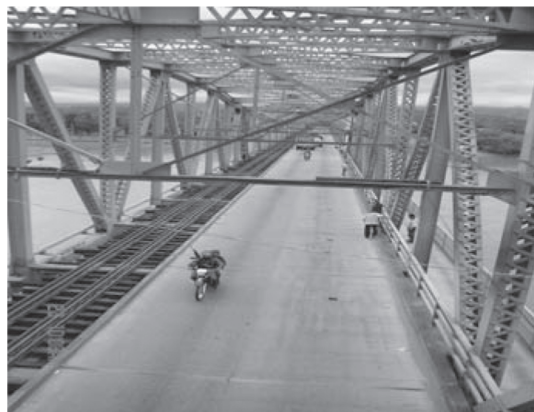
Figura 13. Puente sin carga vehicular. Fuente: (Los autores).
