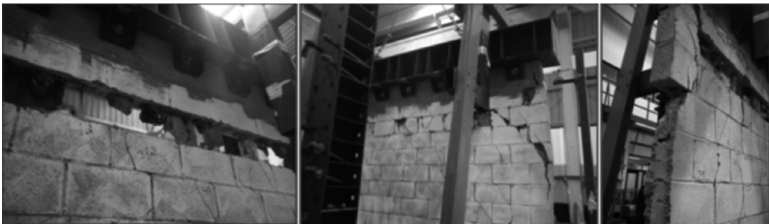
Figura 8. Expulsión de bloques bajo primera hilada en VB1.
