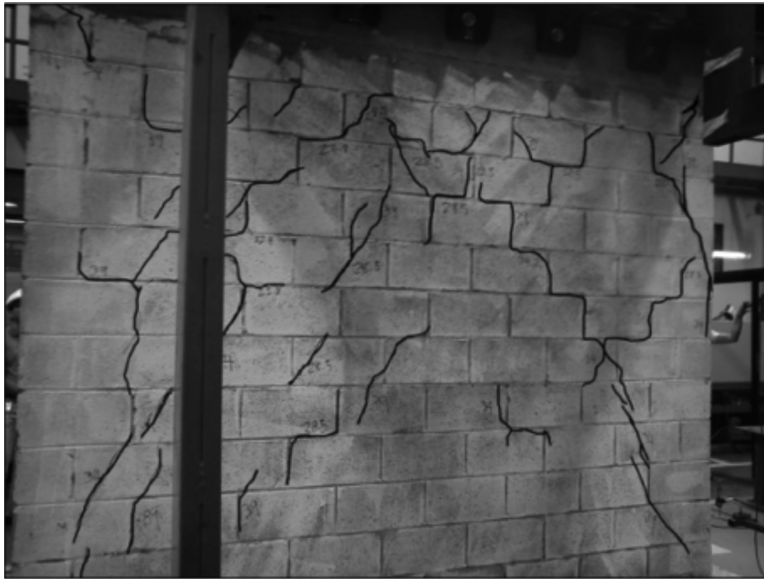
Figura 7. Patrón de grietas en VB1.
