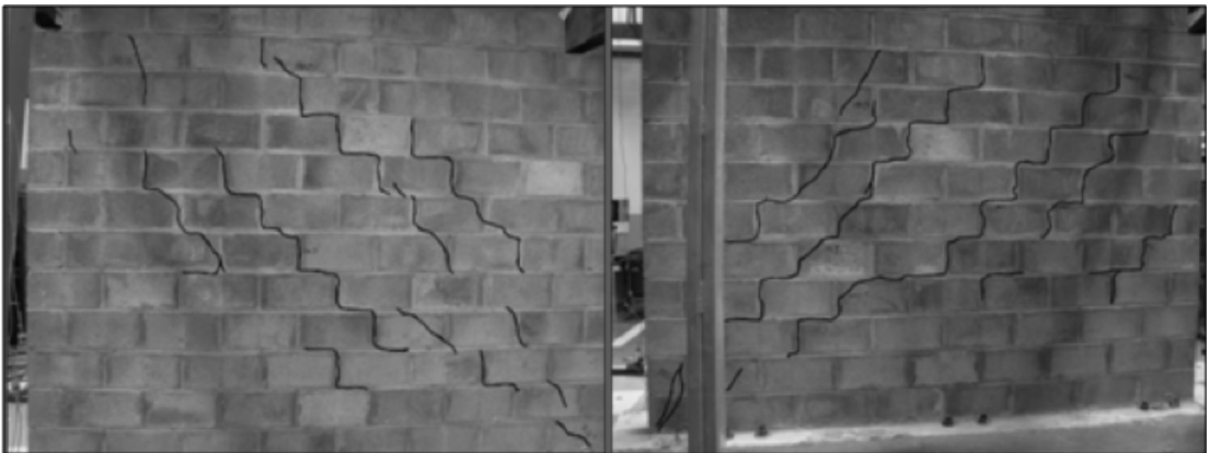
Figura 3. Patrón de grietas en NVB1.
