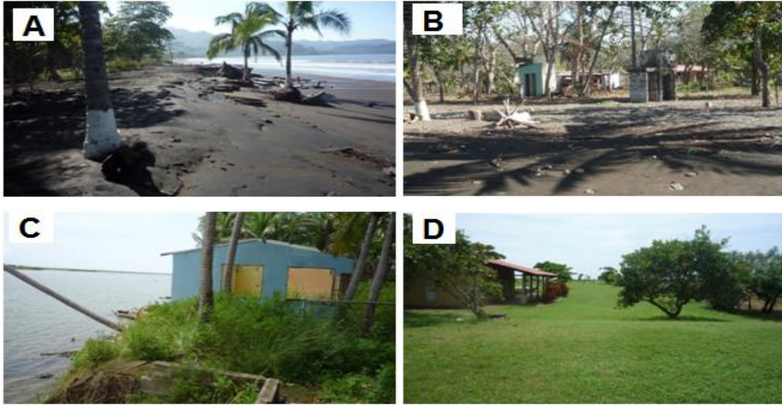
Figs. 6. A y B: fotografías de Playa Azul en febrero del 2010, C: fotografías de destrucción sobre la margen derecha de la desembocadura del Río Tárcoles, y D: fotografía en Carrizal de Bajamar tomadas en setiembre del 2009. Fotos tomadas por O.G. Lizano.
