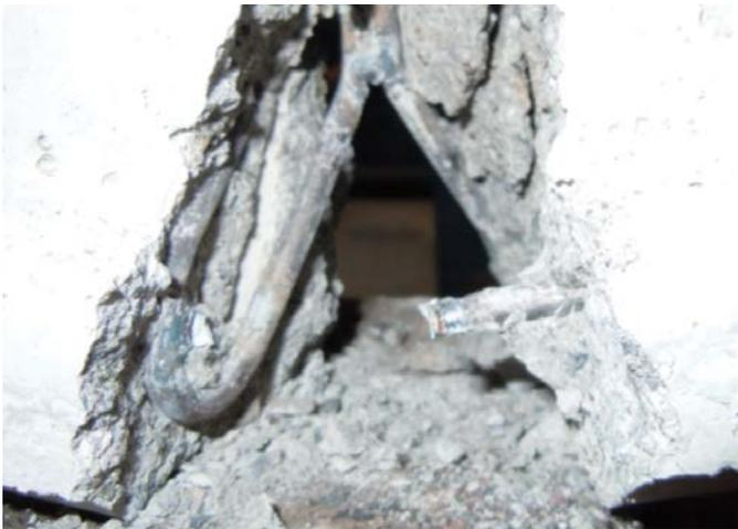
Figura 15. Falla de acero de refuerzo en punto de unión soldada
