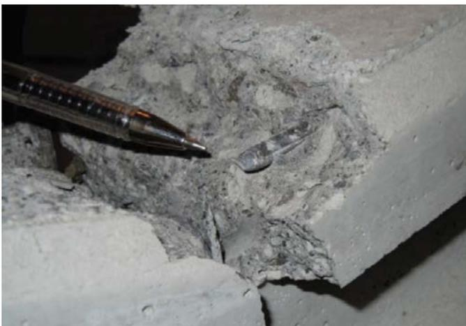
Figura 16. Reducción de diámetro de acero de refuerzo en punto de unión soldada
