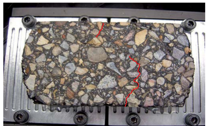
b. Dos grietas
