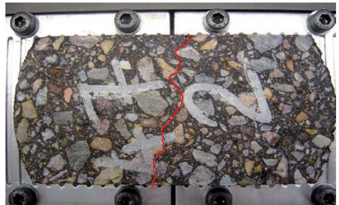
a. Una grieta
