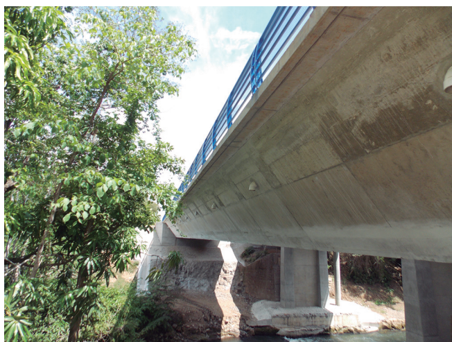
Figura 1. Vista lateral del costado norte del puente sobre el río Tenorio.
