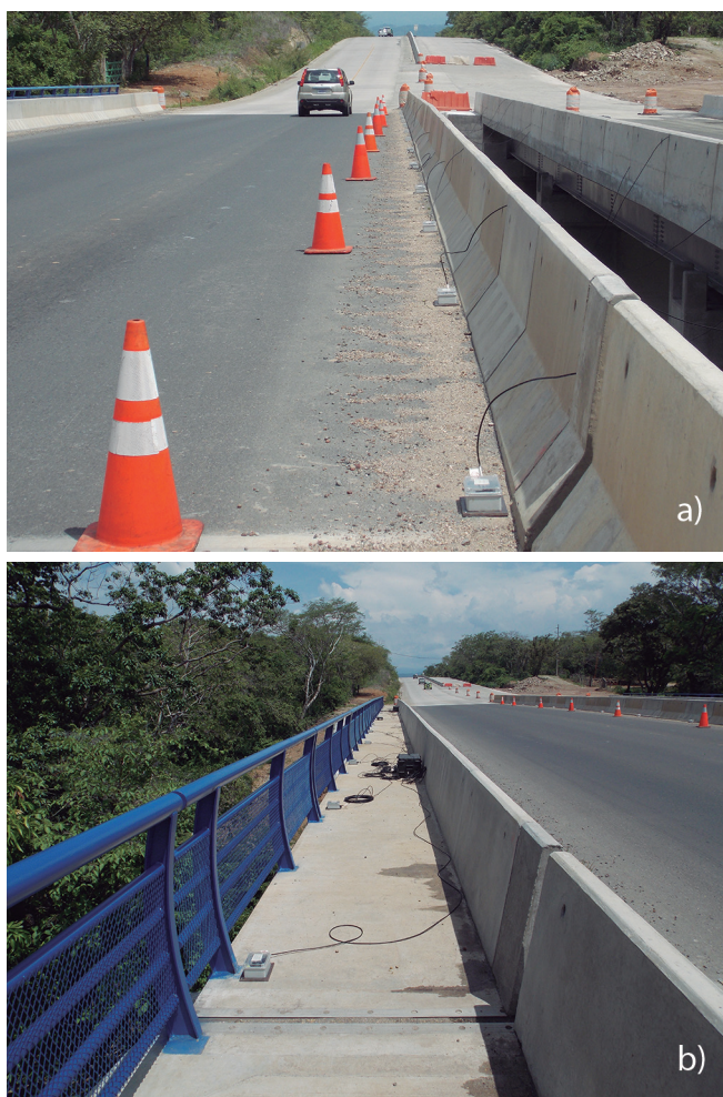
Figura 6. Colocación de acelerómetros en a) costado sur y b) costado norte.
