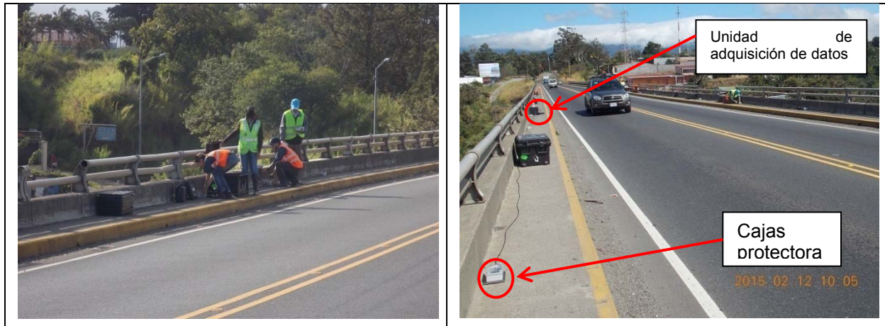
Figura 66. La instalación de los acelerómetros y equipos en las aceras. Nótese que el monitoreo no interrumpe el tránsito de vehículos.
