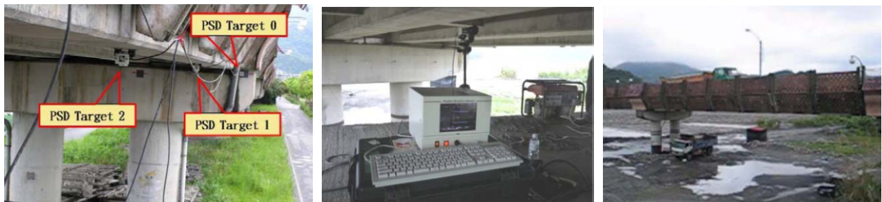
Figura 15. Instalación de los blancos y la cámara del sistema PSD y la prueba de carga. Fuente: Wang et al., 2009 [ref. 37].
