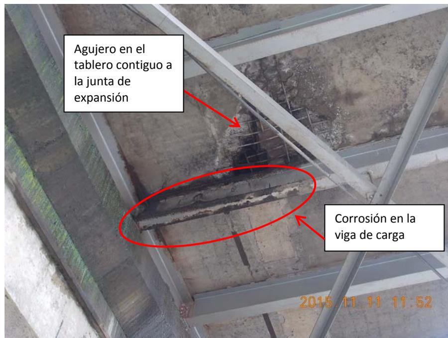
**Figura 14.** Agujero en el tablero y corrosión en viga de carga. Fotografía del día 11 de noviembre del año 2015.
