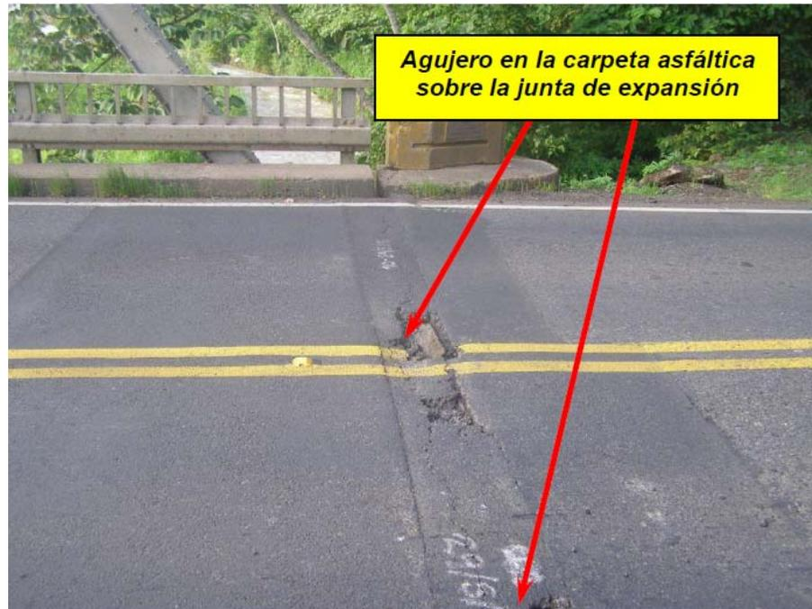
**Figura 7.** Fotografía tomada del informe de inspección visual de noviembre del 2011 [ref. 3] presentado el estado observado de la junta.
