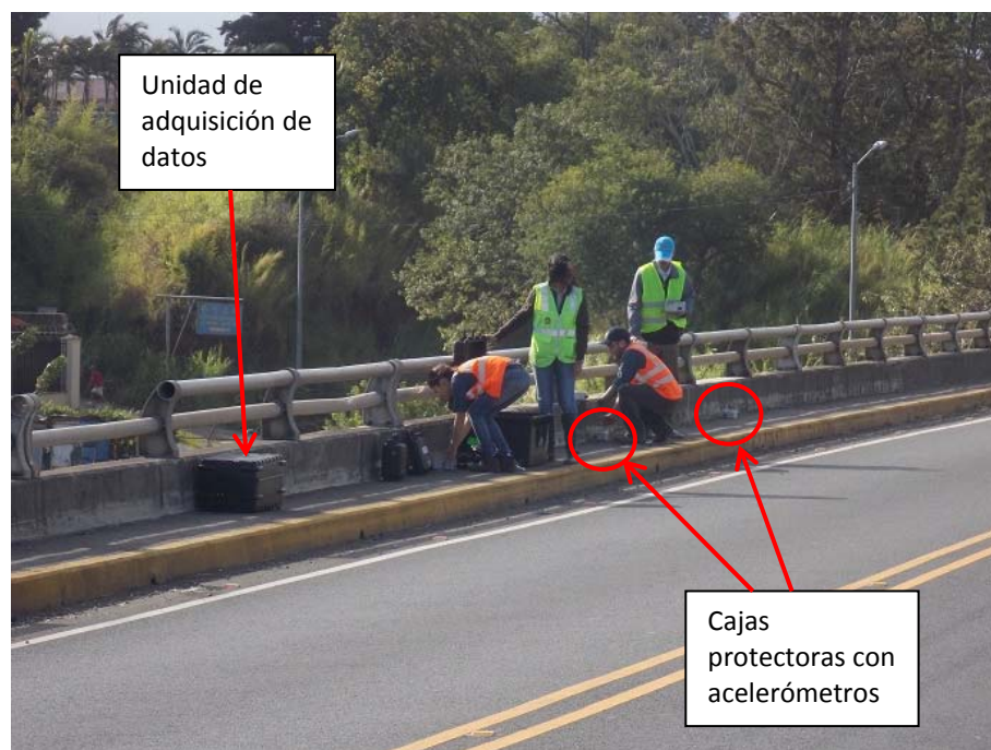
Figura 7. Colocación de sensores en las aceras del puente.
