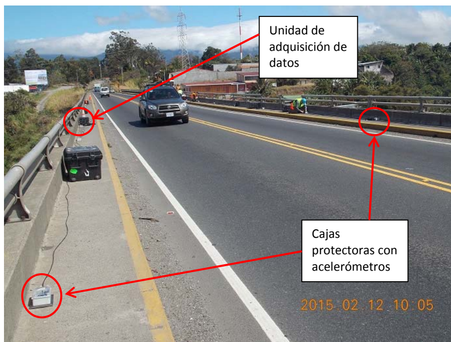
Figura 11. Vista de superestructura con equipos en las aceras. Nótese que el monitoreo no interrumpe el tránsito de vehículos.
