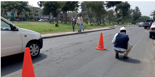
Figura 3. Inspección en campo
