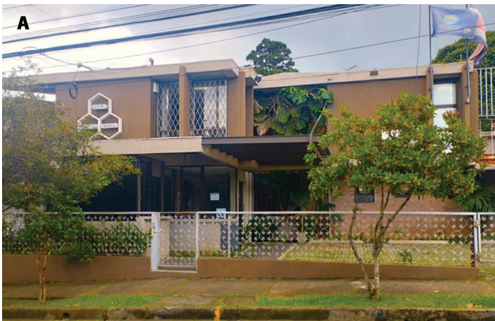
Fig. 49. A. Edificio actual del CCT; B. Tosi.
