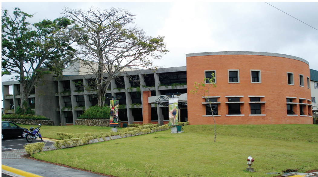
Fig. 78. Edificio actual de la OET.
