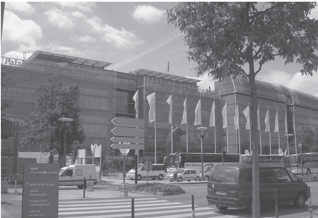
Foto 2. Centro de intercambio de Perrache. Centro multimodal (terminal de buses, estación ferroviaria, metropolitana y tranvía.) con un pequeño mall de estilo americano. El eje principal de las autopistas francesas pasa bajo este complejo realizado en la década de 1970 y co-financiado por el Estado y la alcaldía de Lyon. (Foto P. Boino)
