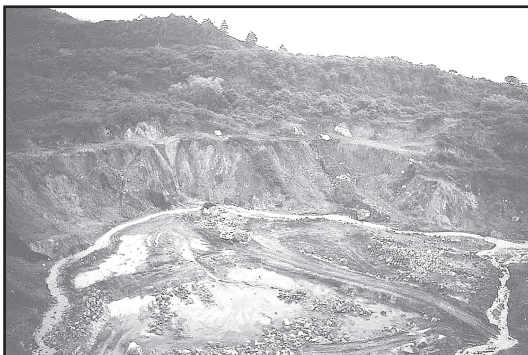
Foto 2. Deslizamiento de San Blas. Obsérvese la maquinaria que trabaja extrayendo material de la base del deslizamiento, y que contribuye así a la desestabilización de la masa deslizante.
