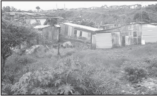
Foto 3. Casas en la zona de los diques, muchas de las cuales están construidas con materiales muy frágiles. También se observa que algunas de las viviendas se han construido en el lecho de inundación del río, mientras que otras están ubicadas sobre los diques.
