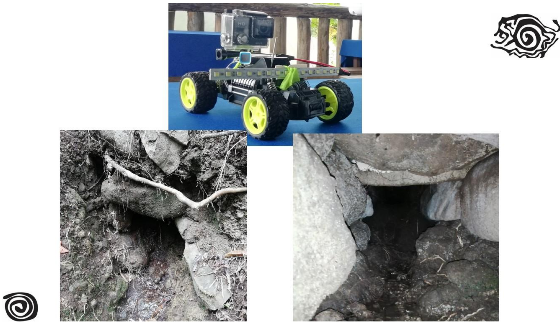
Figura 4. Rover utilizado e introducido en el canal subterráneo que desfoga el agua de la caja de agua 2 del sitio Rosa María. Abajo a la izquierda la salida del canal; abajo a la derecha cómo es el canal por dentro.
