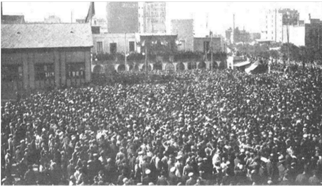
LAS INMEDIACIONES DE LA CASA DEL PUEBLO MOMENTOS ANTES DE LA LLEGADA DE LERROUX Foto: Pastur
