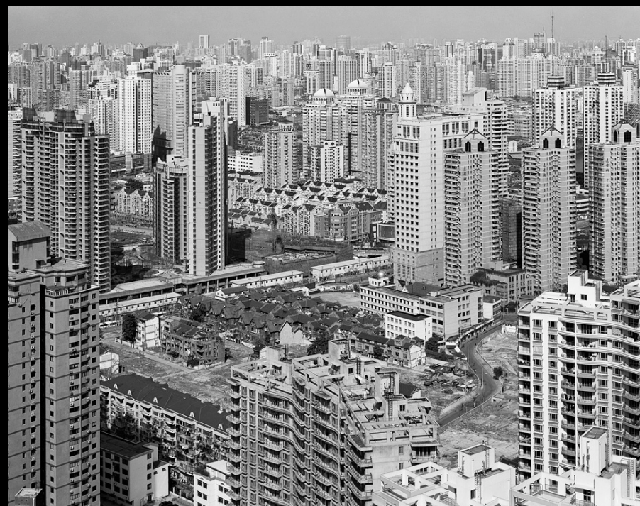
Figura 1. Shanghai, Renovación Urbana. ©Edward Burtynsky.
