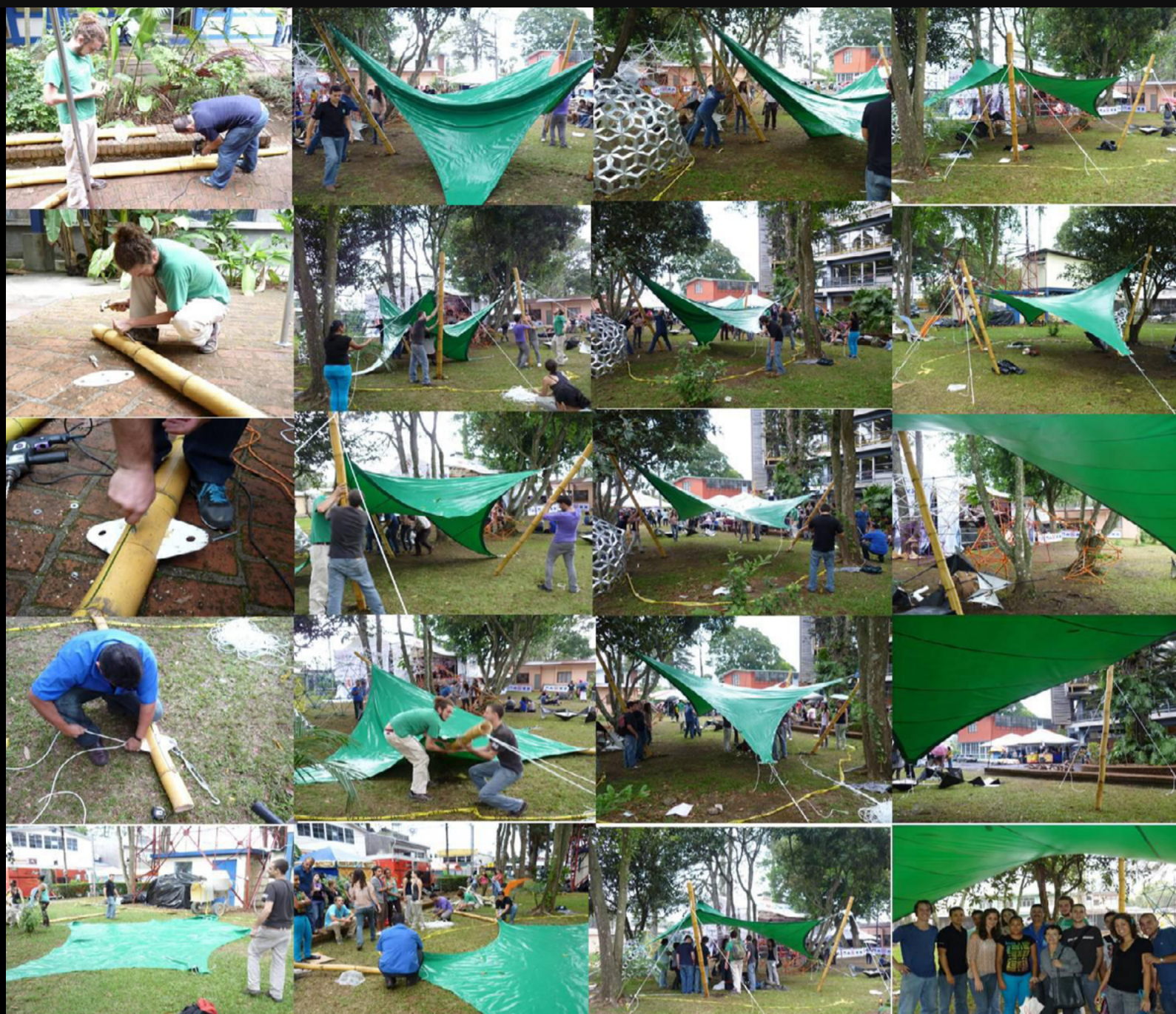
Figura 9. Proceso de instalación.
