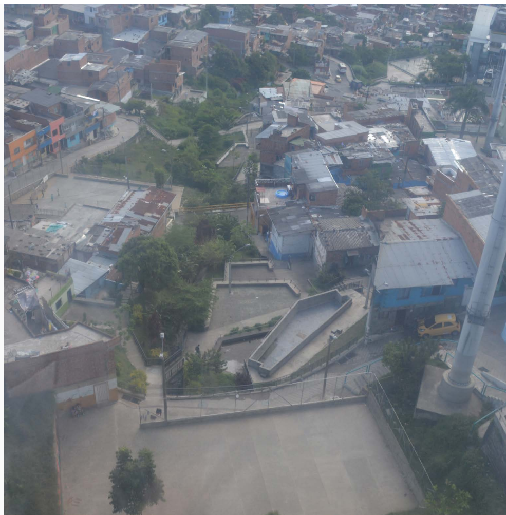
Figura 7. Parque lineal quebrada la Herrera. Imagen del estado actual de las piscinas. Fuente: Lautaro Ojeda, 2015.
