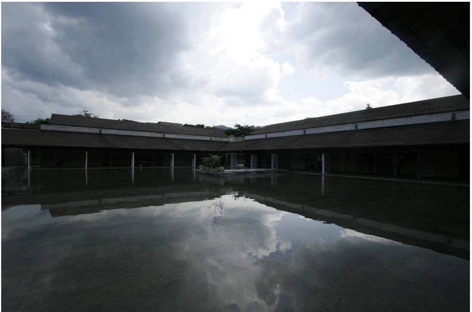
Figura 10. Fotografía del patio de agua de la Biblioteca Belén. Fuente: Massimo Palme, 2014.
