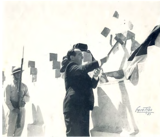
Ilustración 3. Figueres derribando el torreón del Museo. Fuente: archivonacional.go.cr
