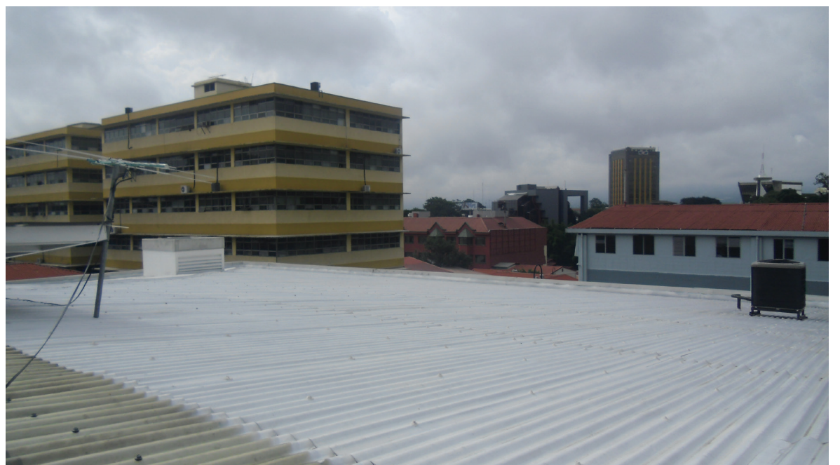
Figura 11. Fotografía de la cubierta del edificio SJ-2.
