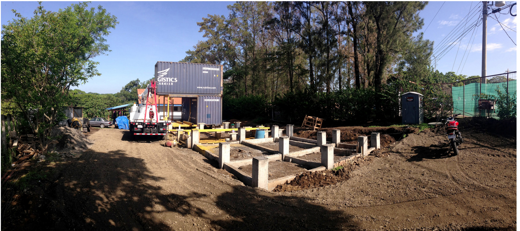
Figura 9. Sistema de cimentación. Fotografía: Francisco Vásquez May.
