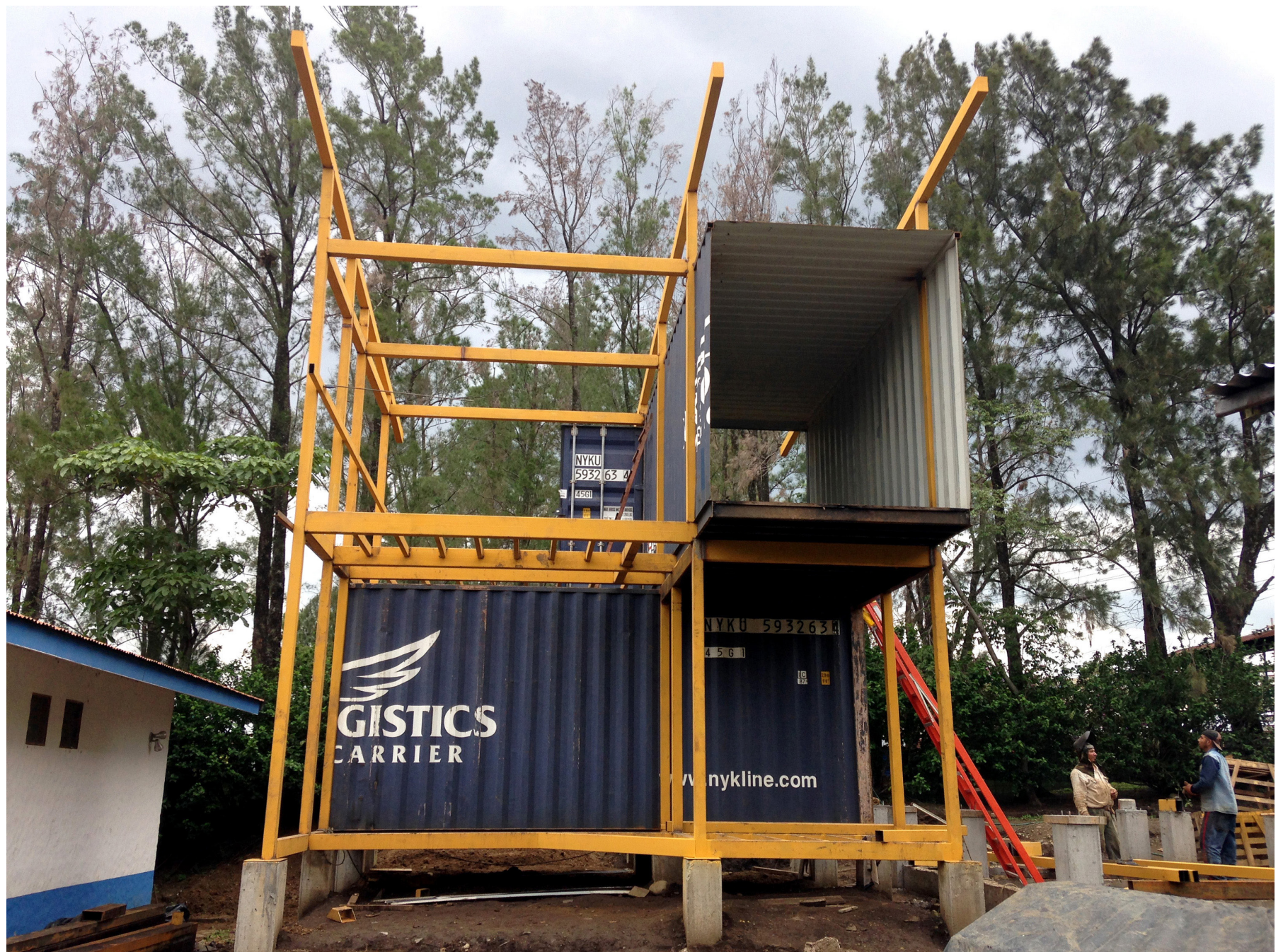
Figura 10. Construcción de estructura primaria. ▼
